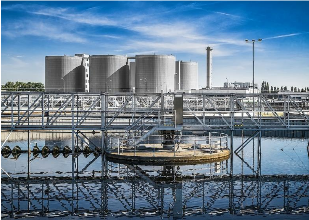
Faulbehälter der Wiener Kläranlage
